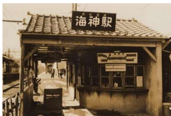
昭和 30 年頃の下り駅舎
