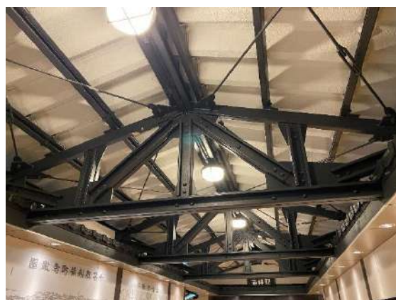
跨線橋天井部
