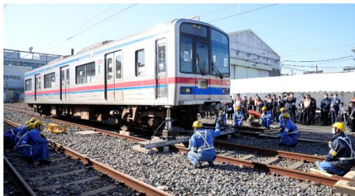
① 脱線復旧(宗吾車両基地)
