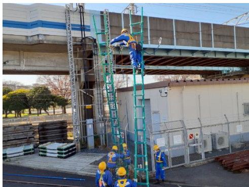
③ 電車線復旧(高砂車庫)
