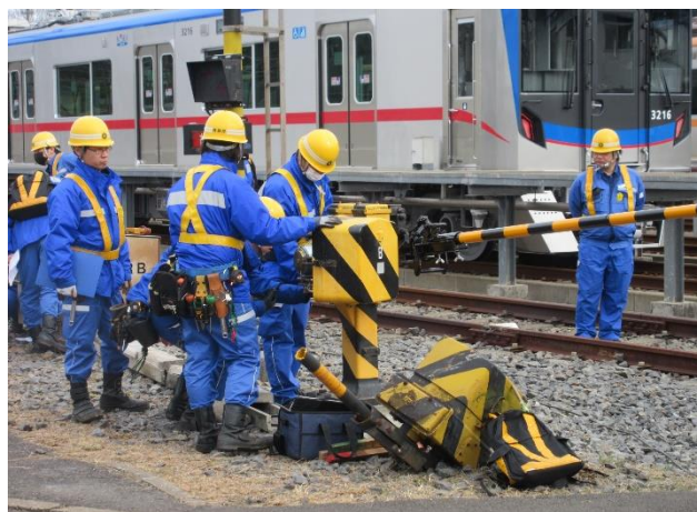
信号機倒壊復旧訓練
