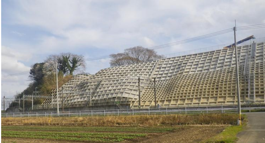
京成臼井～京成佐倉間の法面補強
