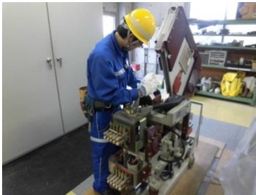
変電設備検査
