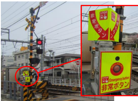
踏切支障報知装置（非常ボタン）
