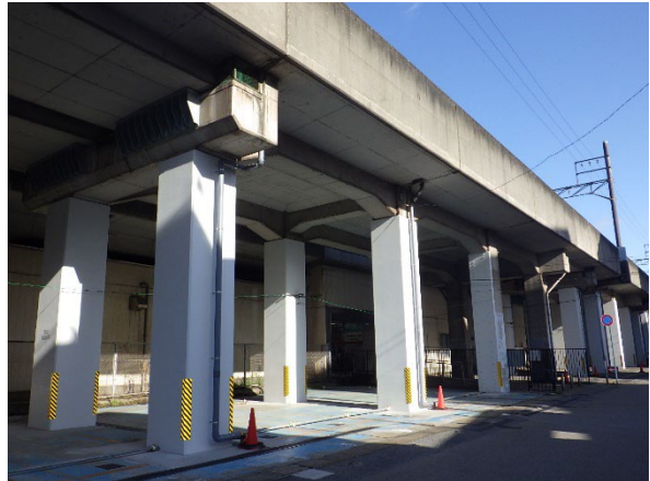
千原線高架橋耐震補強工事
