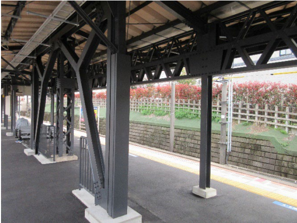
耐震補強工事が完了した東中山駅ホーム上屋
