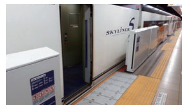
成田空港駅くし状ゴム
