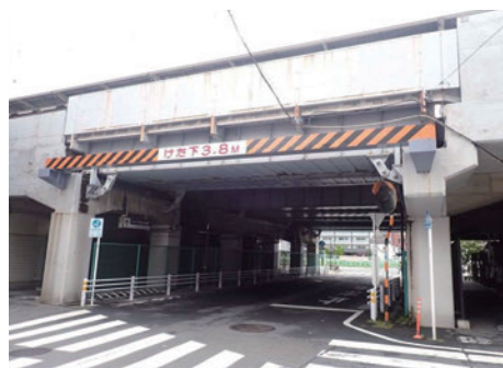
防護柵設置当時
