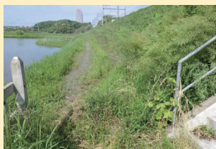
立入防止柵 施工前
