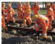
マクラギ更换の様子
