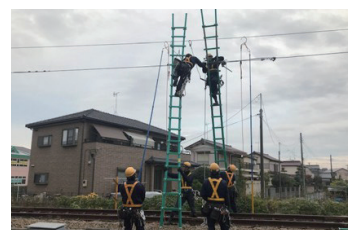
架線断線復旧訓練
