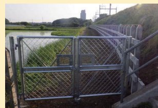
立入防止柵 施工後
