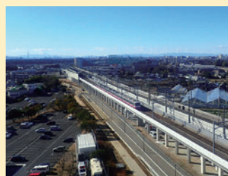
鎌ヶ谷市内連続立体交差
