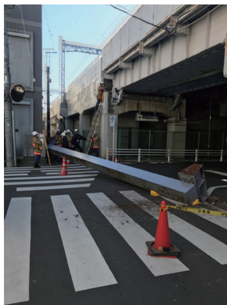
防護柵落下直後
