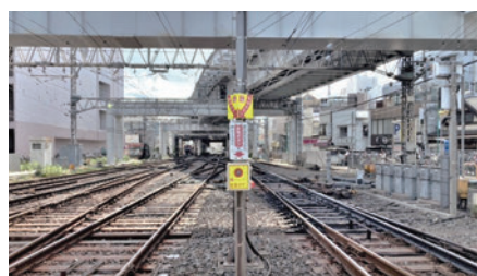
踏切内の非常ボタン
