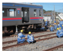
脱線復旧の様子
