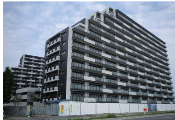
分譲マンションの新築工事
