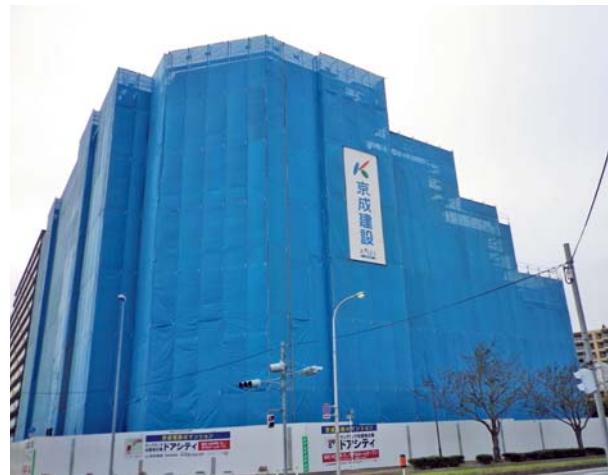
分譲マンションの新築工事
