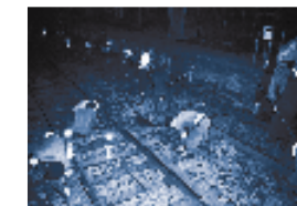
夜間の改軌工事 (昭和34年)
