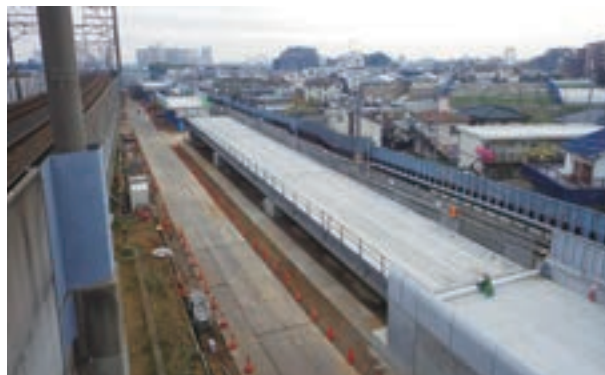
鎌ヶ谷市内の新京成線連続立体交差事業
