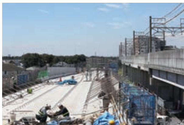
新京成線連続立体交差事業に伴う北初富駅建築工事
