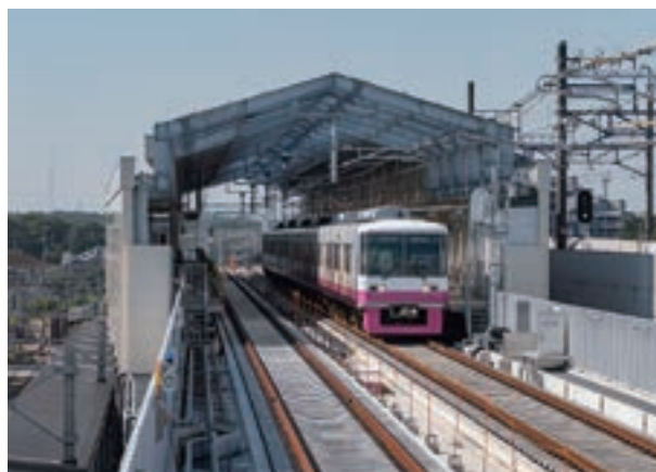
新京成線連続立体交差事業に伴い高架化した北初富駅下りホーム
