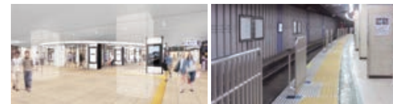
リニューアル後の京成上野駅構内（イメージ） 京成上野駅全ホームに設置された固定柵
