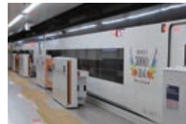
空港第2ビル駅のホームドア
