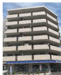
船橋市前原西の賃貸施設
