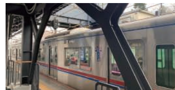
耐震補強後のホーム
