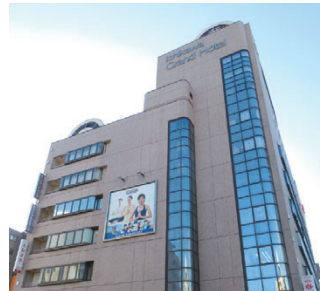
市川市市川賃貸施設
