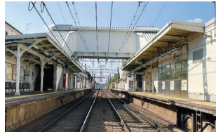
リニューアルされた跨線橋
