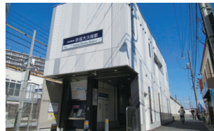
上りホーム駅舎外観
