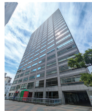
墨田区錦糸町駅前オフィスビル
