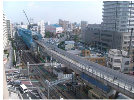
墨田区内連続立体化工事 押上駅～京成曳舟駅間 計画線高架橋
