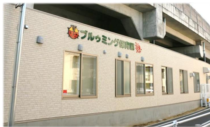
船橋市高架下保育施設
