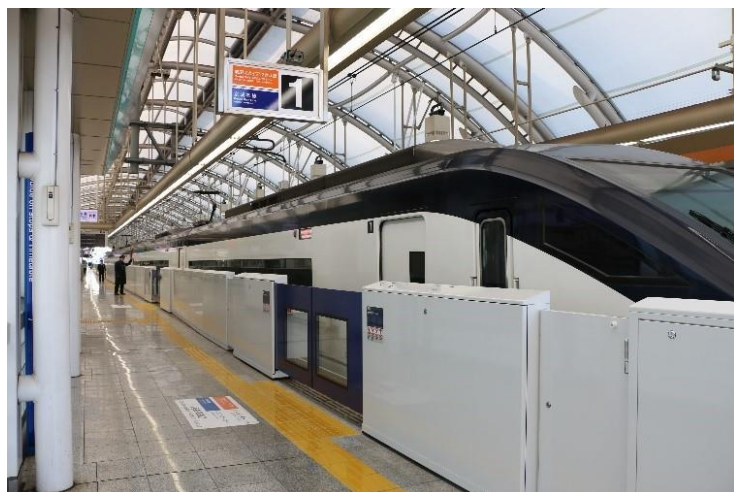
ホームドア (写真は日暮里駅下りホーム)
