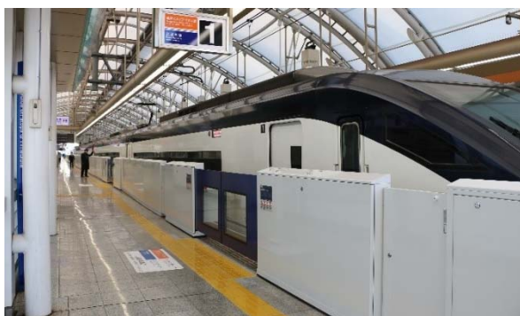
ホームドア (写真は日暮里駅下りホーム)
