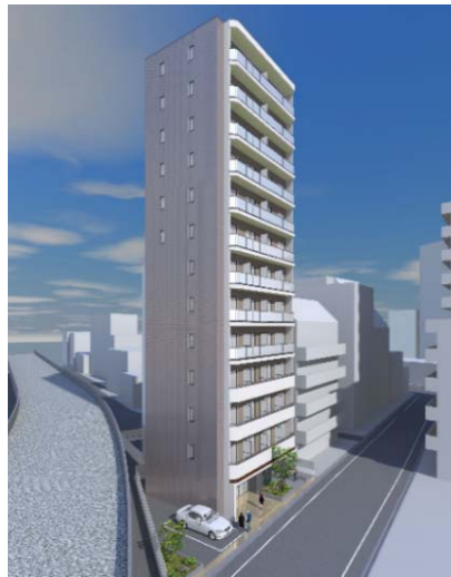
台東区根岸賃貸マンション
