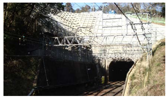
補強した法面 (写真は宗吾参道駅~公津の杜駅間)
