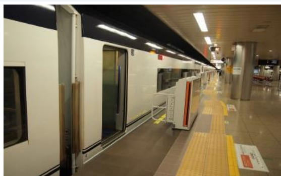
成田空港駅に設置したホームドア
