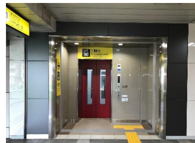
八千代台駅に設置したエレベーター
