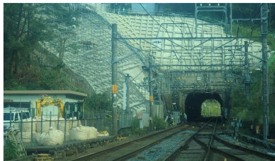
法面補強工事 (宗吾参道駅~公津の杜駅間)
