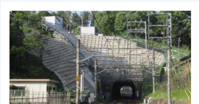
法面補強工事 (宗吾参道駅～公津の杜駅間)
