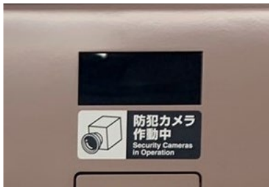
車内への防犯カメラの設置
