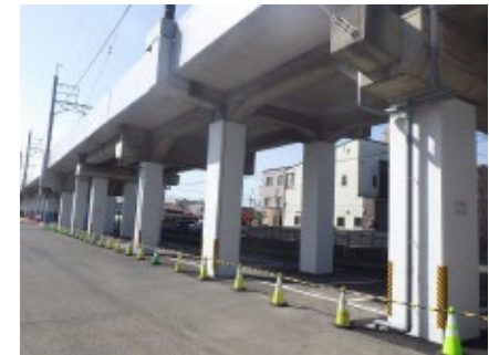
耐震補強後の高架橋柱
