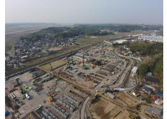
宗吾車両基地拡充工事（2025.4現在）
