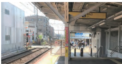
京成大久保駅ホーム上家耐震補強
