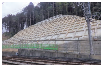
法面補強工事
