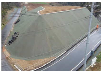
圏央道多古地区改良工事
