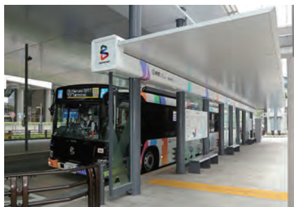
東京BRT停留施設 (新橋駅)
