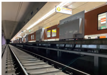
成田空港駅ホームドア整備工事
