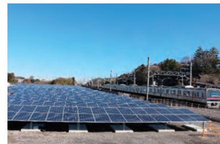
ちはら台太陽光発電所
