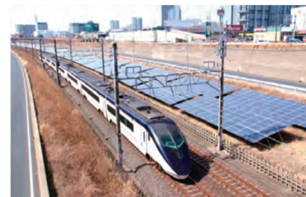
SGET 千葉ニュータウンメガソーラーの横を走行するスカイライナー
