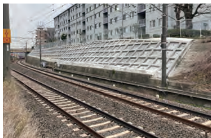
谷津駅～京成津田沼駅間の法面補強工事
