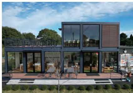
タケエイエコパークゴルフ大木戸クラブハウス新築工事
