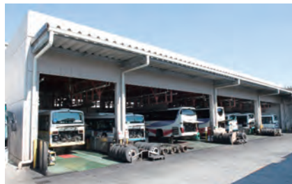
船橋整備工場(京成自動車整備)
