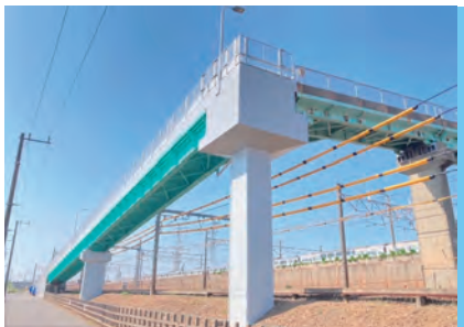
宮の台跨線橋補修工事
