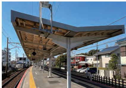
鬼越駅ホーム上家耐震補強に伴う建築工事
