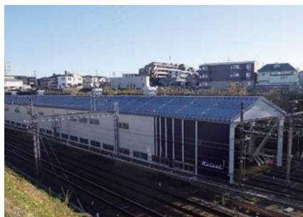
津田沼車庫耐震補強外壁改修
