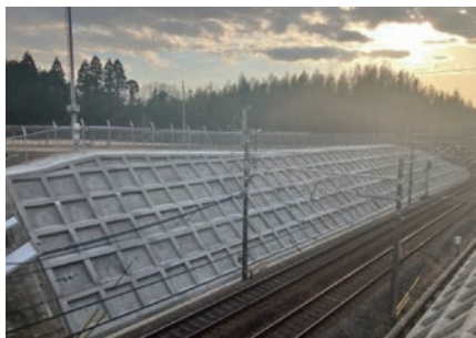
成田～駒井野信号場上り線法面防護工事
