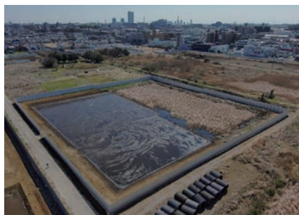
海老川調整池掘削工
