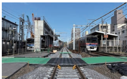
押上線連続立体交差事業
