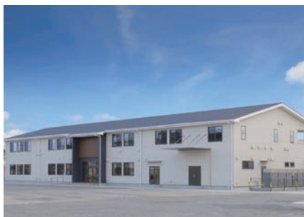
小湊鉄道塩田営業所新築工事
